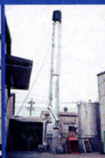
▲コンビネーションスパレスター (火の粉防止 防音 スパレスター+サイレンサー)
